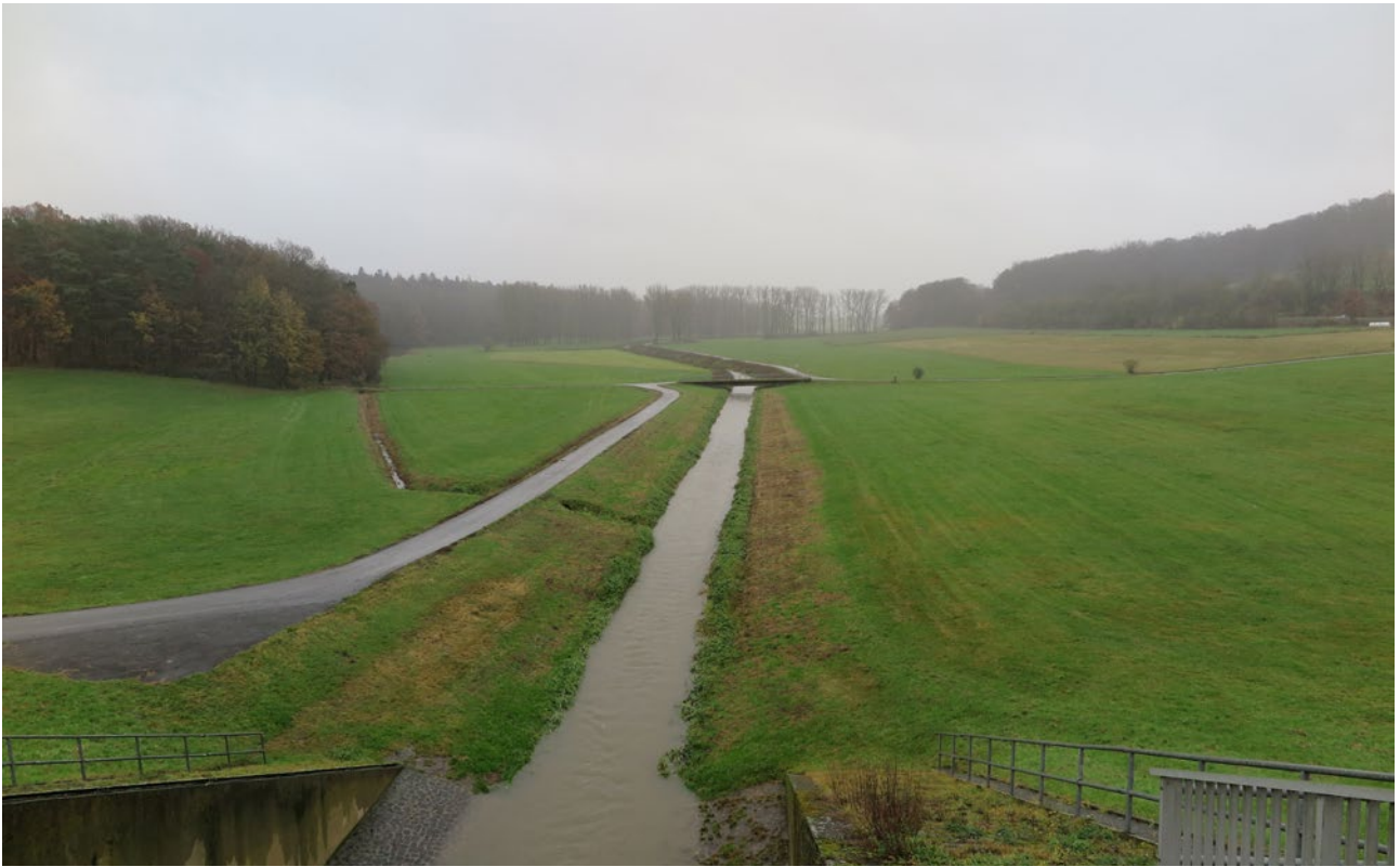
Abb. 36: Blick in den Stauraum des HRB Heidelberg © HLNUG
