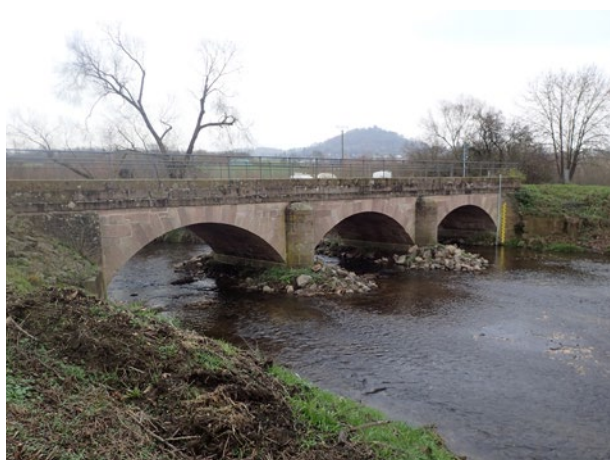
Abb. 62: Brücke über die Efze mit Laufverengung (Abschnitt 64) © Ann Katrin Thomas, HLNUG
