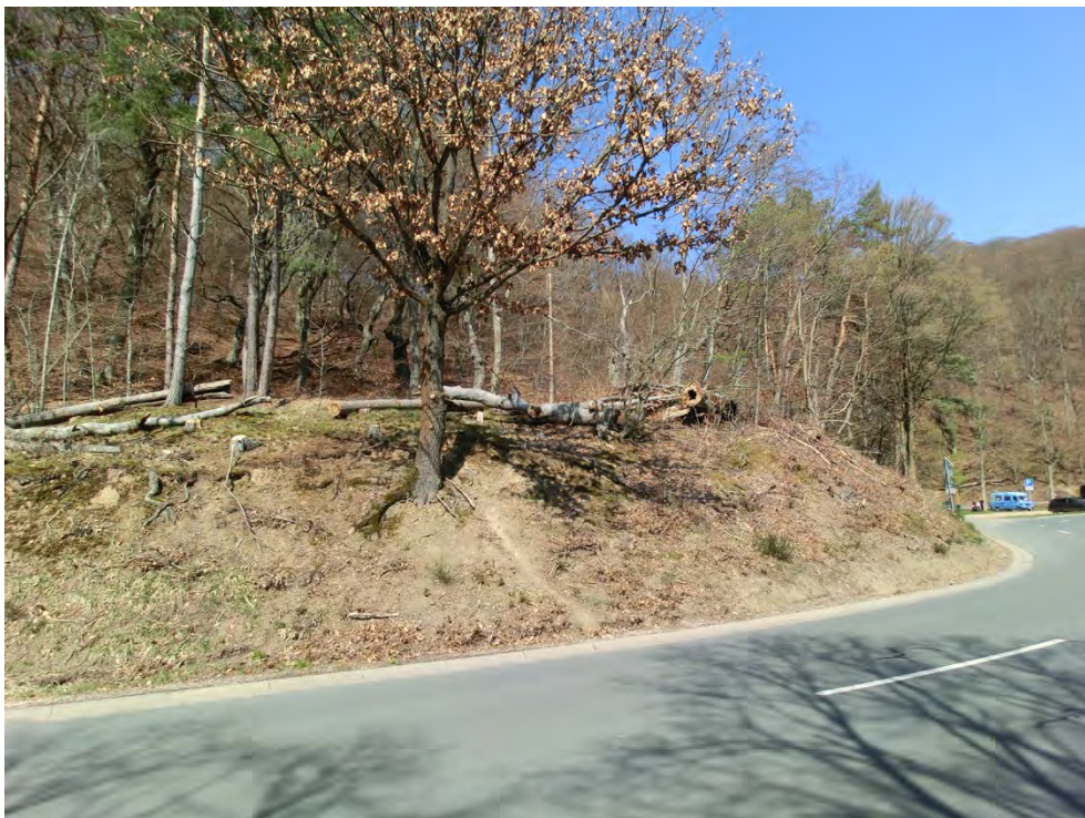
Abb. 28: NLP Kellerwald-Edersee. Waldeck, Edersee-Randstraße. Das Plateau neben der Straße war im Gegensatz zu den umliegenden Steilhängen gut zu begehen und zu untersuchen. Das Bild zeigt auch deutlich die durch Wegesicherungsmaßnahmen entstandenen Schäden im Altbaumbestand.
