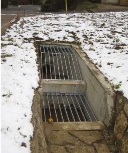
*Abbildung 33: Rechen, der Verstopfung durch Geschwemmsel und Treibgut vorbeugt (LUBW 2016, S.44)*
