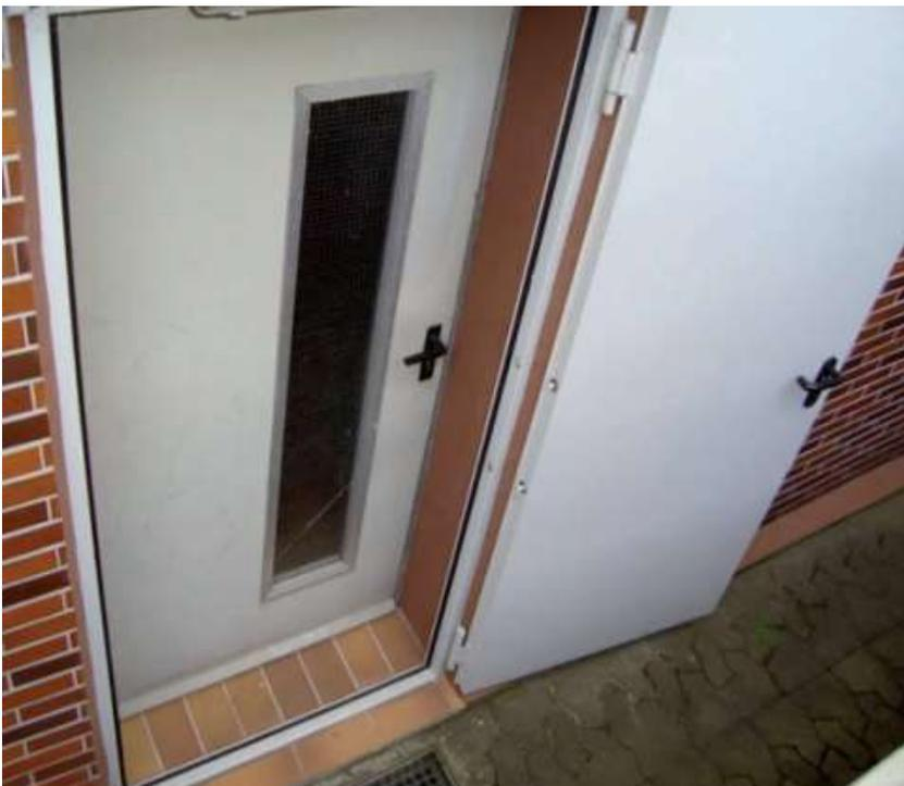
Abbildung 57: Nachträgliche Einbauten an einer Tür zum Schutz gegen eindringendes Wasser (ibh und WBW 2013, S. 43)
