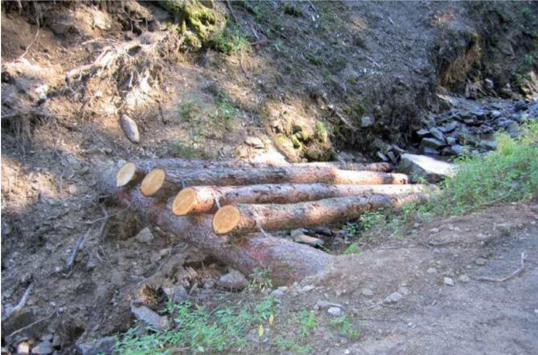
*Abbildung 29: Rechen mit Materialien des Waldes zum Rückhalt von Treibgut (ibh und WBW 2013, S. 35)*
