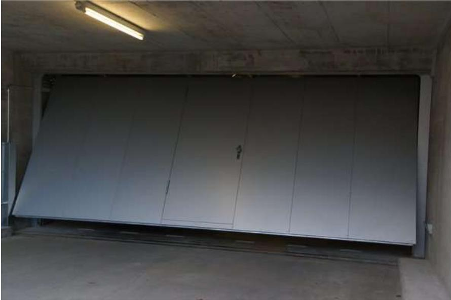
Abbildung 56: Grundstücksabschlußstor von Hydrotool ([Hochwasserschutz Kipptor](http://Hochwasserschutz_Kipptor) ([Wasserdichtes Tor](http://Wasserdichtes_Tor)) ([hydrotool.ch](http://hydrotool.ch)))
