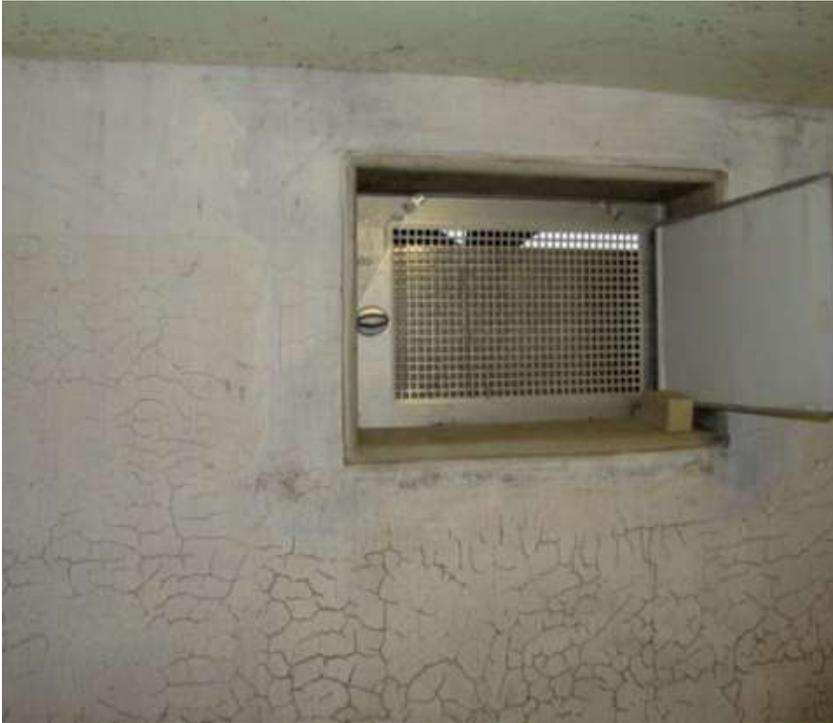
*Abbildung 58: Nachträgliche Einbauten an einem Fenster zum Schutz gegen eindringendes Wasser (ibh und WBW 2013, S. 43)*
