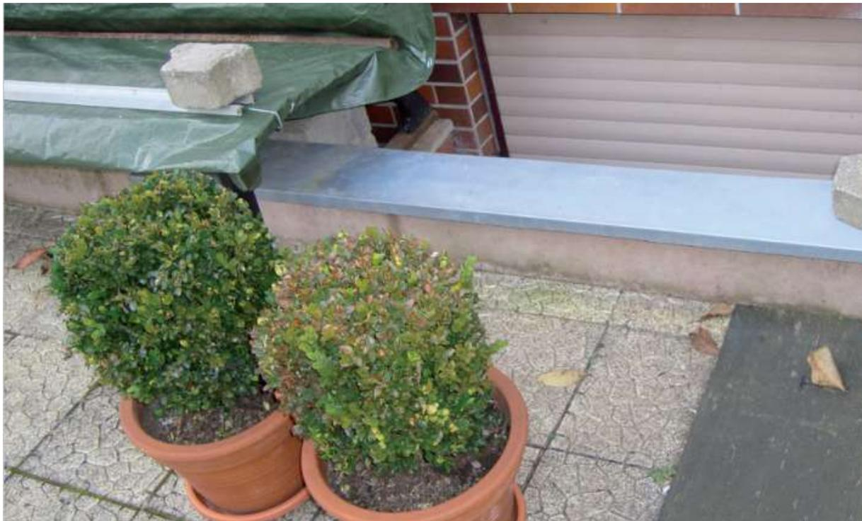
Abbildung 55: Hochgemauerter Kellerfensterschacht (ibh und WBW 2013, S. 43)
