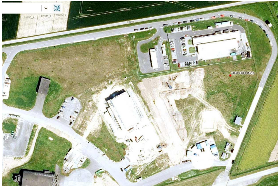
Abb. 4: FIS AG 2024 - AREA 12 - Auto-Skill-Center und Parkplatzneubau
