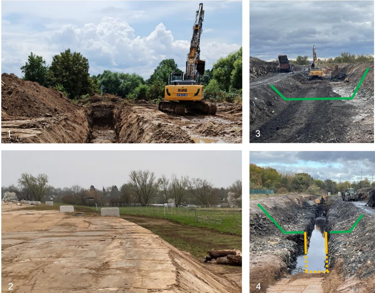
Abb. 6: 1 Erkundung Dichtwandtrasse (BA 1); 2 Randdamm mit gesicherten Grundwassermessstellen (BA 3); 3 Voraushubebene und 4 Tiefenaushub (BA 4)
