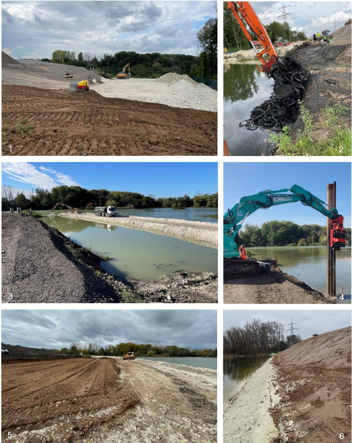
Abb. 7: 1 Dammbau mit Stabilisierung (helles Material, BA 5); 2 Entfernung der Störstoffe auf dem Seegrund (BA 6); 3 Einbau der Vorschüttung (BA 6), 4 Proberammung (BA 6); 5 Verfüllung des Dammbbeckens und 6 Dammaufbau (BA 6)
