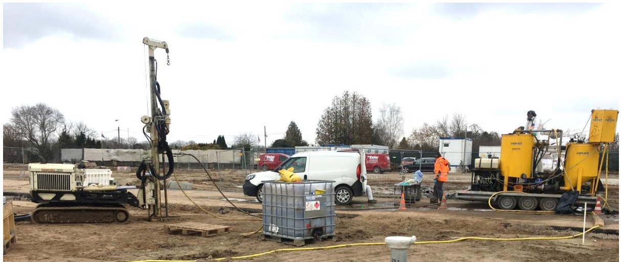
Abb. 3: EHC-Eingabe (Bohrgerät links, Mischanlage rechts)
