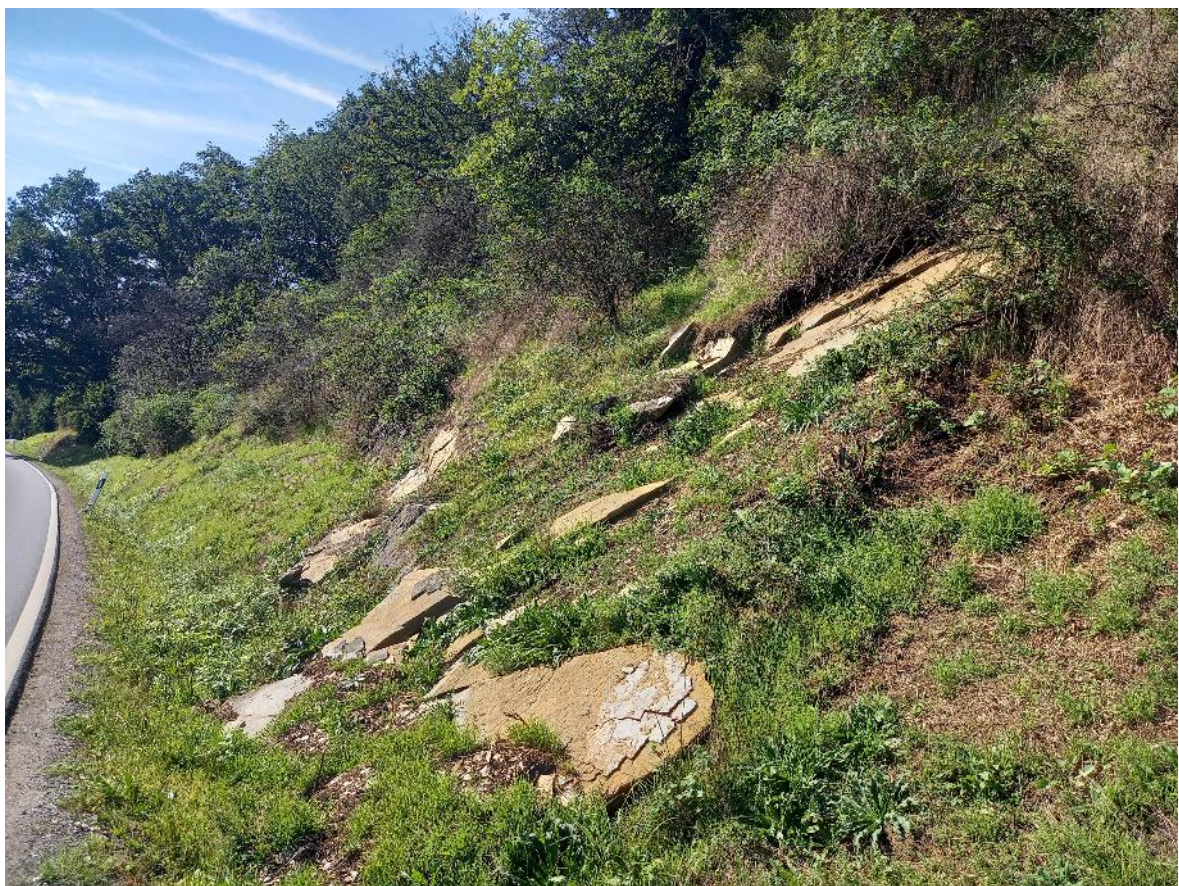
Abbildung 1: Steiler Bereich der Straßenböschung mit Felsblöcken und nach oben angrenzenden Trockengebüschen. (Foto: R. Polivka).
